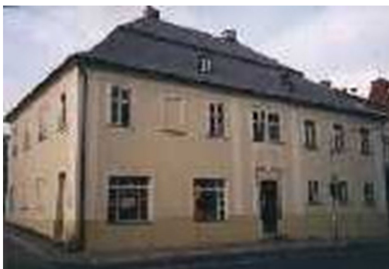
Pfarrhaus nach der Rekonstruktion
