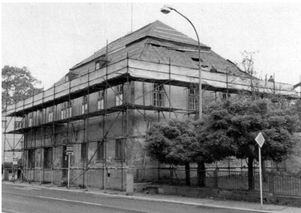
1992 - Das Dach wird saniert und die Innenrenovierung begonnen. Das Haus füllt sich wieder mit Leben.
