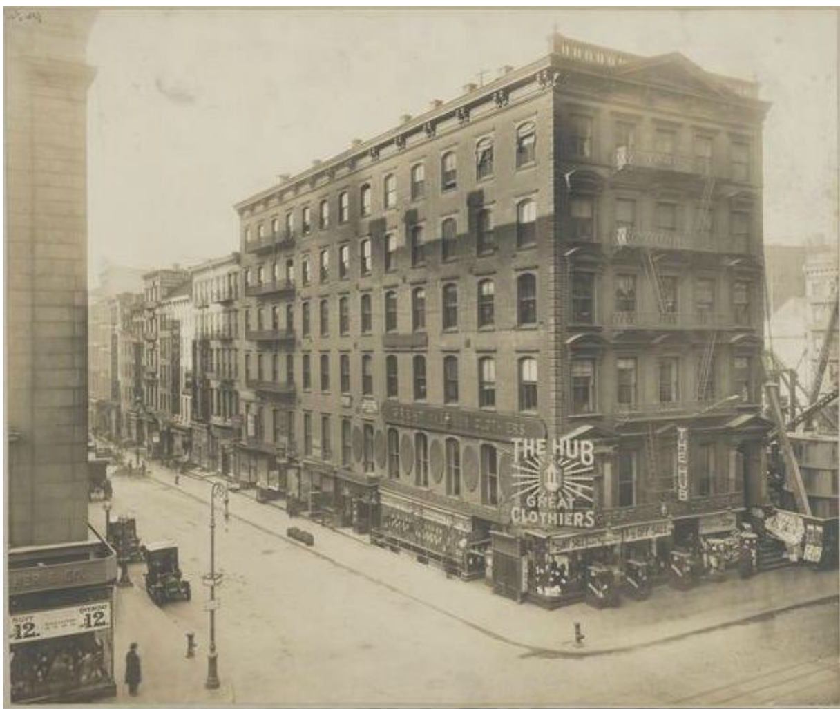
Broadway 229. Die Häuser rechts daneben befinden sich schon im Abriss. Hier entsteht das neue „Woolworth Building“
